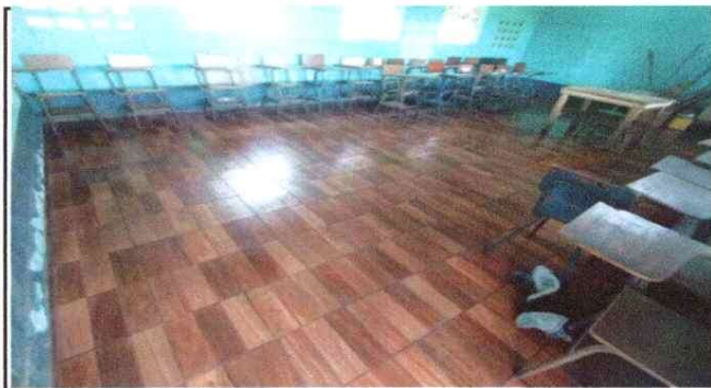
Foto 3: Sustitución de Piso Cerámico en Aulas.
