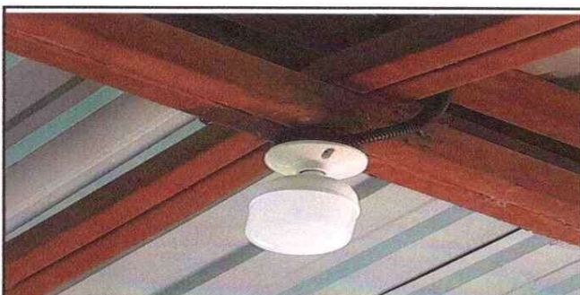
Foto 6: Sustitución de Focos y plafoneras en aulas.
