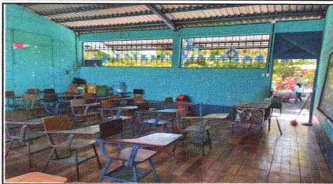
Foto 2: Sustitución de Piso Cerámico en Aulas.
