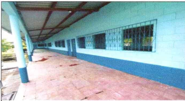
Foto1: Mantenimiento a Puertas de Metal
