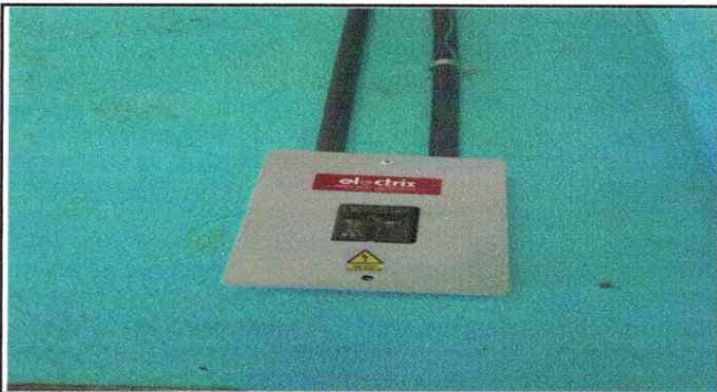
9. sustitucion de tableros y flipones
