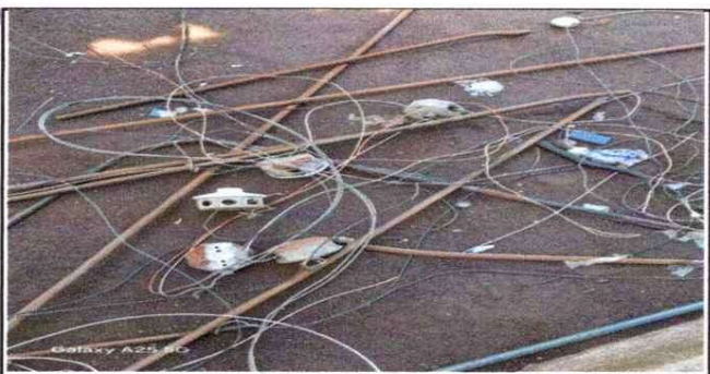
Foto 5: Reparacion de Sistema Eléctrico en General-
