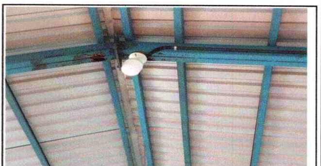
Foto 6: Sustitución de Focos y plafoneras en aulas.
