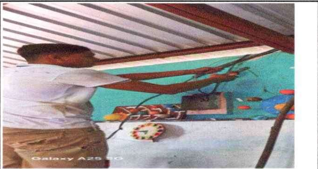
9. sustitucion de tableros y flipones
