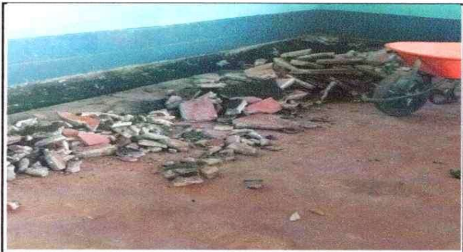
Foto 3: Sustitución de Piso Cerámico en Aulas.
