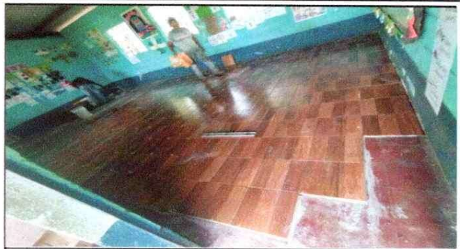
Foto 2: Sustitución de Piso Ceramico en Aulas.
