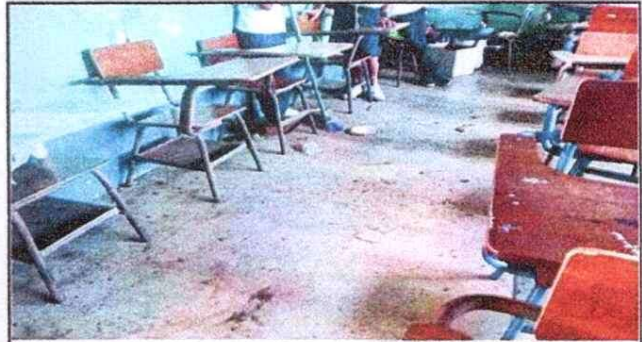
Foto 2: Sustitución de Piso Cerámico en Aulas.
