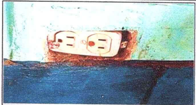
17.8 Sustitucion de tomacorrientes
