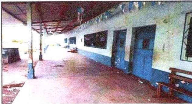
Foto 1: Mantenimiento a Puertas de Metal
