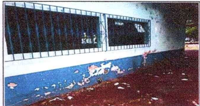
Foto 4: Aplicación de Pintura en muros de concreto de aulas.
