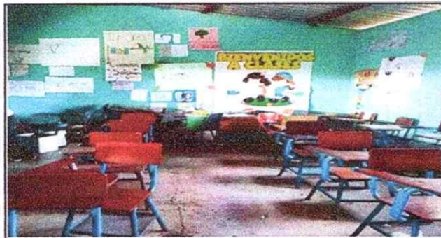
Foto 3: Sustitución de Piso Cerámico en Aulas.
