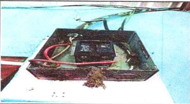
7.10 sustitucion de tableros y flipones
