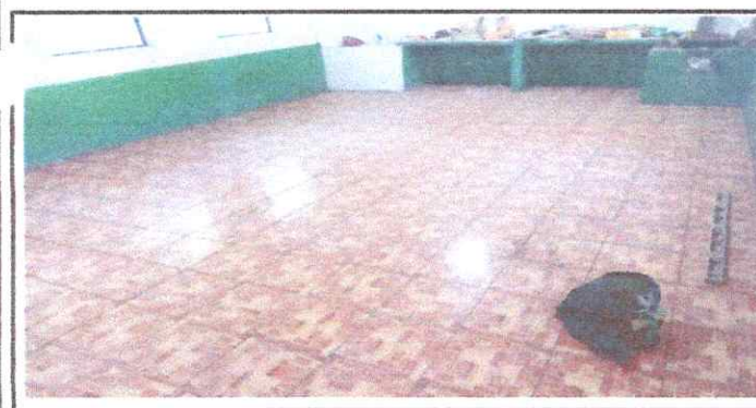
Foto 5: Sustitución de piso de granito por piso cerámico antideslizante del área de la cocina.
