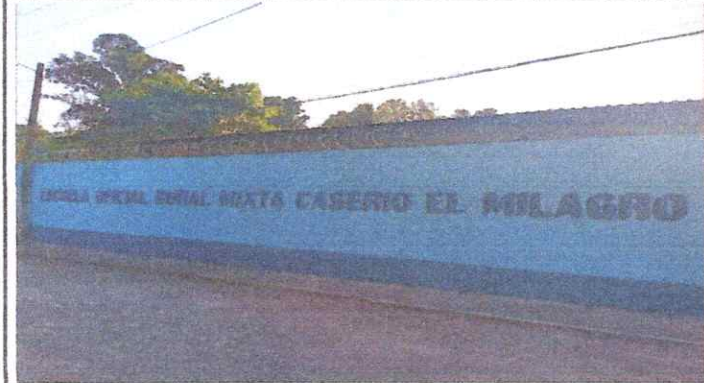
Foto 1: Sustitución de malla por pared (block), levantar dos bloques más y oclar rasor, con la finalidad de asegurar la Escuela. Sernido y pintura en el exterior.
