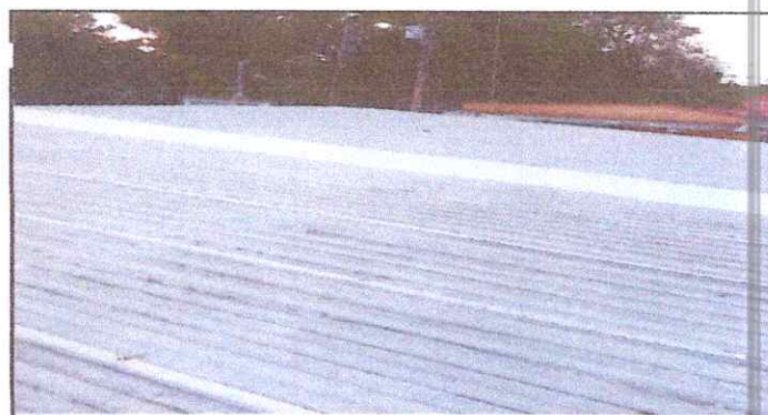
Foto 6: Sustitución de cuatro láminas, con sus respectivos elementos de fijación (tornillos).
