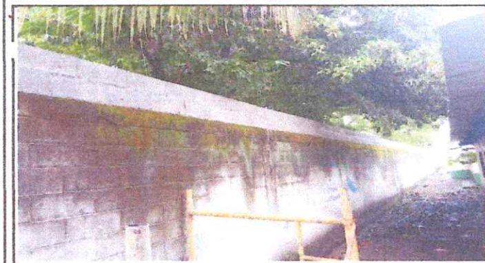
Foto 3: Se levantaron dos bloques más de block y se taparon los agujeros con cemento. Con la finalidad de seguridad al edificio público.
