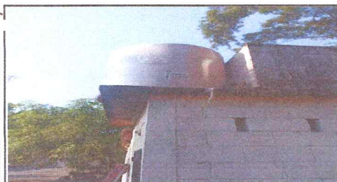
Foto 3: Se cambio el depósito de agua a uno de 1100 litros.
