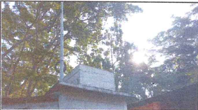
Foto 3: Sustitución de depósito de agua 1000 litros. (EN PROCESO PARA EL 28/11/2024)
