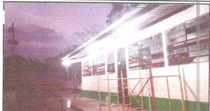
Foto 2: Sustitución de bombillas y reflectores y cambio de elementos deteriorados o dañados (cables, plafoneras, apagadores, etc.)
