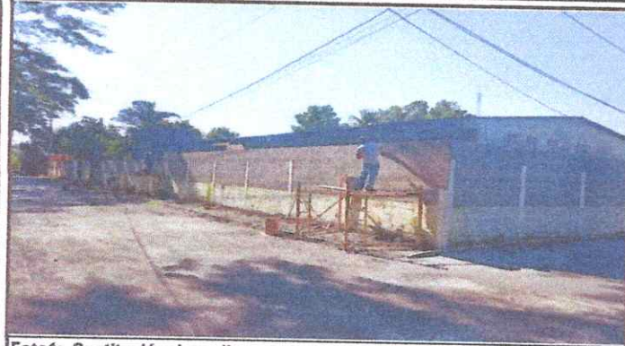
Foto 1: Sustitución de malla por pared (block), levantar dos bloques más y colocar rasor, con la finalidad de asegurar la Escuela. Sernido y pintura en el exterior.
