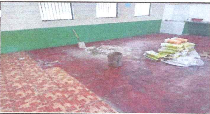
Foto 5: Sustitución de piso de granito por piso cerámico antideslizante del área de la cocina, como mejorar la estufa rural y su chimenea, como el tanque o pileta que se encuentran para el uso de la cocina.
