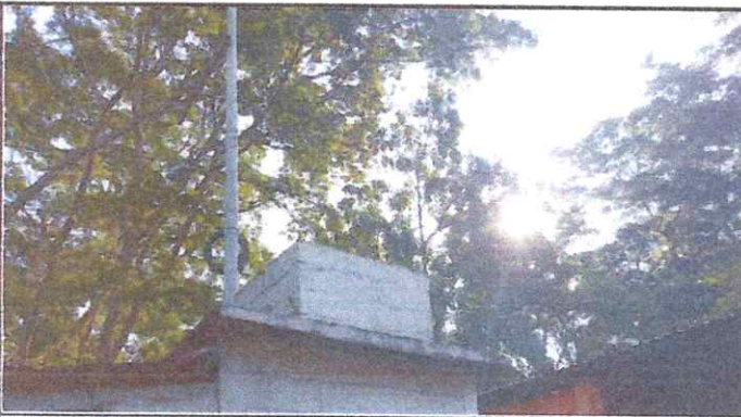
Foto 3: Sustitución de depósito de agua 1000 litros.
