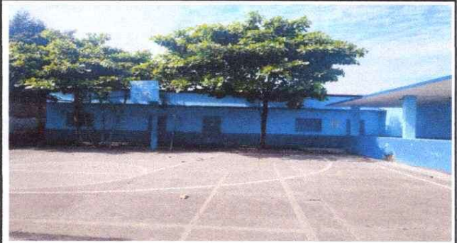
Foto 2: PINTURA DE MUROS EXTERIORES.
