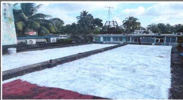
Foto 3: IMPERMEABILIZACION DE LOSA.
