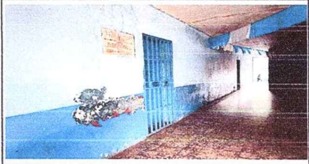
Foto 2: Pintura de muros exteriores
