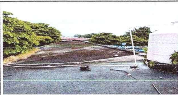
Foto 3: Sustitución de tubería línea principal.
