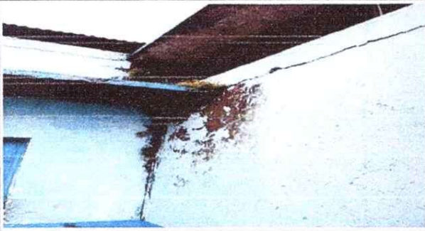
Foto1: Pintura de muros exteriores
