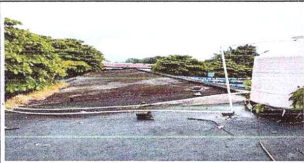
Foto 3: Sustitución de tubería línea principal.
