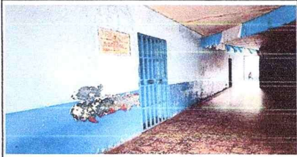
Foto 2: Pintura de muros exteriores
