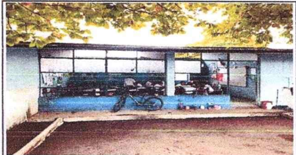
Foto 4: Sustitución de ventana de vidrio por muro de block en módulo aula.
