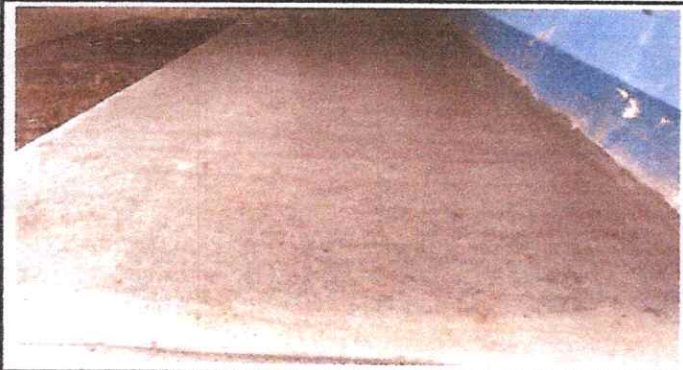
Foto 3: FINALIZACIÓN DE BANQUETAS A LADO IZQUIERDO Y DERECHA.
