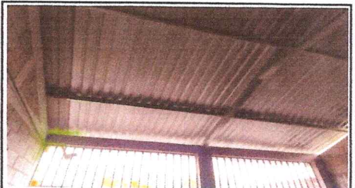
Foto 4: FINALIZACIÓN DE TECHADO DE LÁMINAS AL SALÓN DE CLASES.
