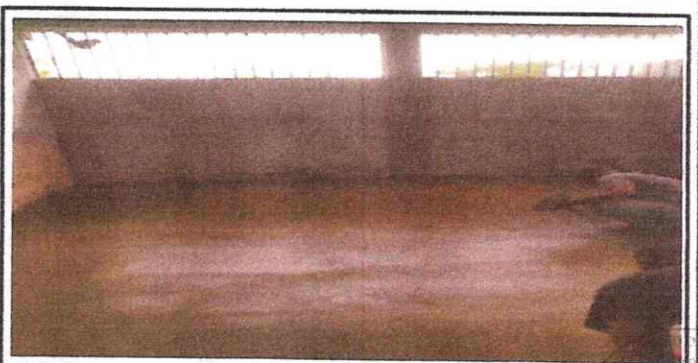
Foto 6: FINALIZACIÓN DE TORTA DE PISO AL SALÓN DE CLASES.
