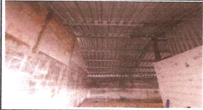
Foto 1: FINALIZACIÓN DE TECHADO DE LÁMINAS A LA COCINA.
