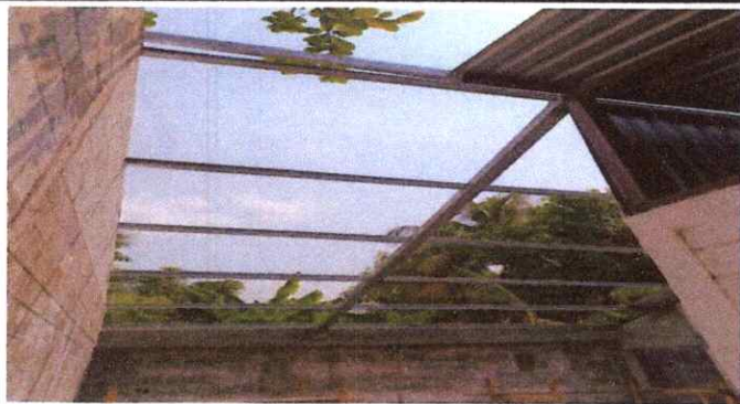
Foto 1: TEJADO DE LÁMINAS A LA COCINA.
