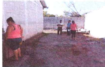
Foto 4: colocacion de costanera entrada al salon
