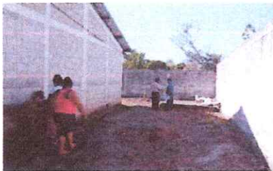
Foto 5: susticion de piso entrada de salon por corriente de lluvia
