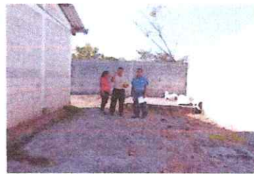
Foto 2: Colocación de piso
