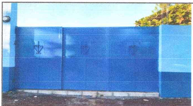
Foto 4: Sustitucion de porton de metal
