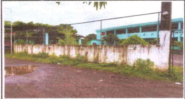
Foto. 2 15.1 Reparación de Muro Perimetral de block .
