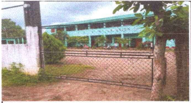
Foto 4. Fabricación de sustitución de portón de metal.
