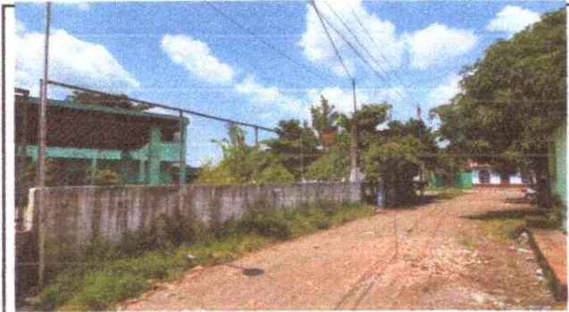
Foto 3. 15.1 Reparación de Muro Perimetral de block.
