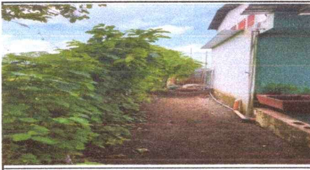
Foto 5. Reparación de muro perimetral de block
