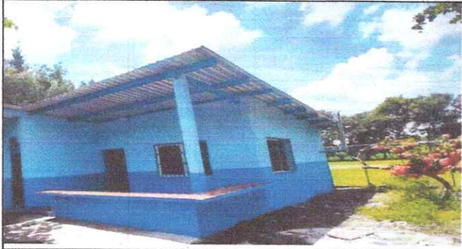
Foto 1. Remozamiento de Cocina
