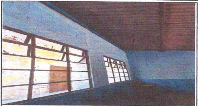
Foto 2. Sustitución de Costaneras en aulas
