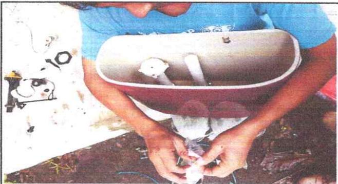
Foto 3: Cambio de accesorios a tanques de sanitarios.
