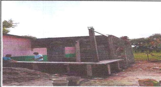
Foto1: Levantado de paredes de cocina
