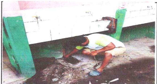
Foto 4: Reparando el tubo del drenaje y llaves de chorro del lavamanos colectivo.
