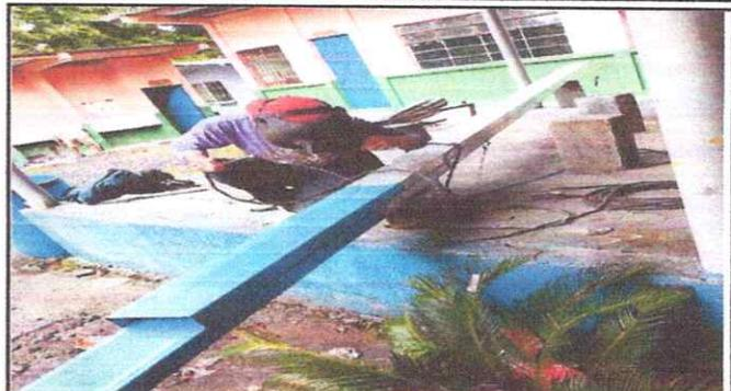
Foto 2: Aplicación de Pintura anticorrosiva para sustitucion de costanera de soporte de metal.
