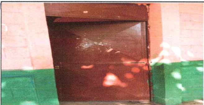
Foto 5. Mantenimiento de estructura de puertas de metal de aulas (lijado, cambio de tubo, cepillado, sujeciones y aplicación de pintura.
