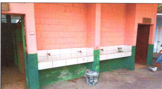
Foto 4. Sustitución de Llaves de chorro y reparacion de drenaje de lavamos colectivo.
