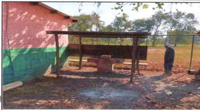
Foto 1. Remozamiento y mejora de cocina, cubierta de lamina, soporte de estructura de metal, paredes, piso, puertas, ventanas, balcones, azulejo y pintura.
