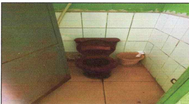
Foto 3. Sustitucion de accesorios de tanque de inodoro, contrallave, manguera de abasto.
