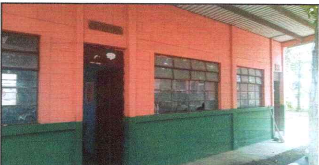
Foto 6. Aplicación de pintura en muros interiores y exteriores.
