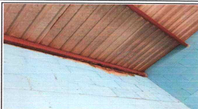
Foto 2. Sustitución de Costanera de soporte de metal en modulo 1 de aulas.
