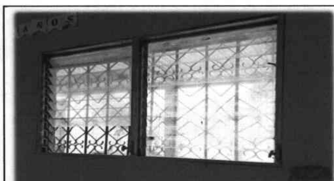
Foto 9: Mantenimiento y Reparación de ventanas metálicas.
