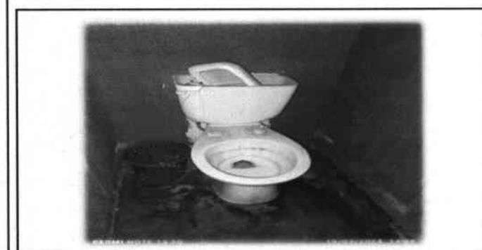
Foto 5: Mejoramiento del módulo de servicios sanitarios con el cambio e instalacion de artefactos sanitarios
