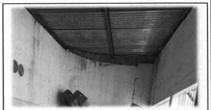
Foto 6: Cambio e instalación de lámina por lámina troquelada aluzinc calibre 26 incluyendo pernos.
