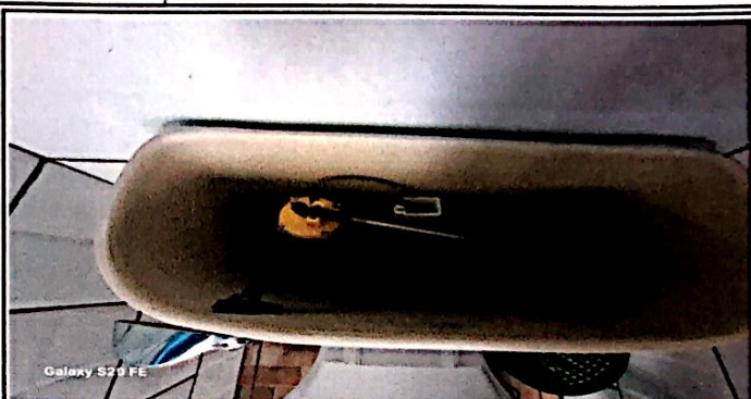
Foto 2: Inсталación de kit para inodoros finalizado.
