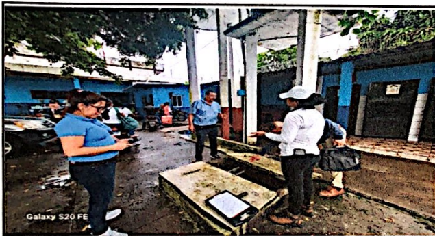
Foto 3: Sustitución de bomba sumergible entregado al 100%.
