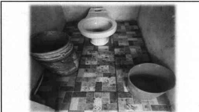
Foto 3: Mejoramiento de servicios sanitarios, incluye reparación cambio de tubería, artefactos, muebles fijos de concreto (pileta, lavamanos y mingitorio) grifos y azulejo.
