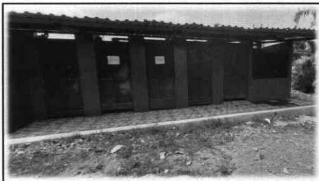
Foto 6: Existe la necesidad de aplicación de pintura al interior y exterior del módulo de servicios sanitarios.
