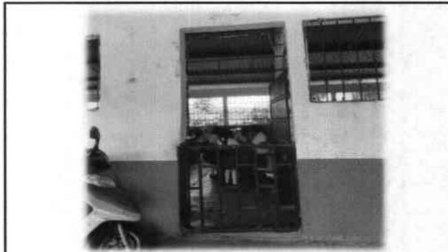
Foto 10: Se detecta la necesidad de dar mantenimiento de puertas , incluye pintura y chapa
