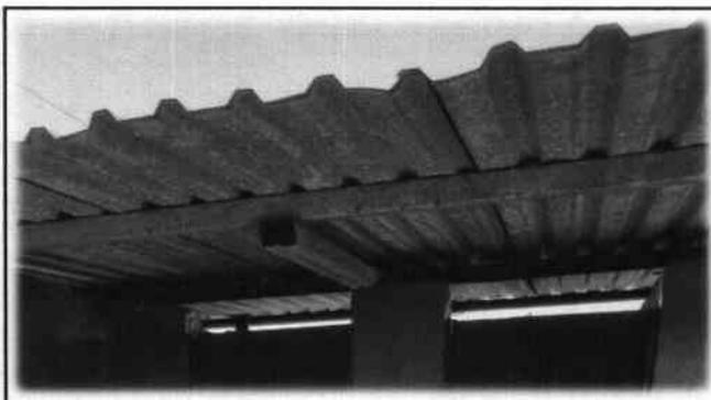
Foto 5: Existe la necesidad de darle mantenimiento a la estructura de soporte de metal.
