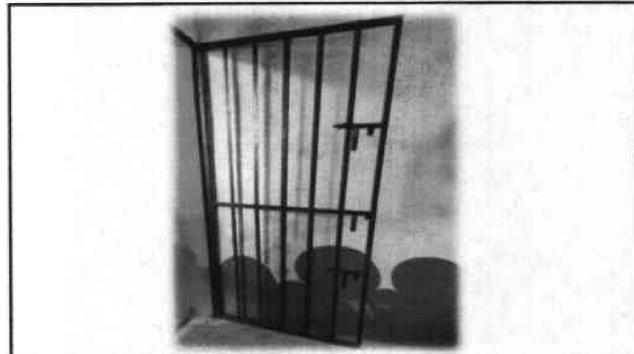
Foto 6: Es necesaria la sustitución de puerta , incluye pintura y chapa.
