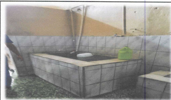
Foto 4: Cambio e instalación de pila de plastico por pileta fundida
