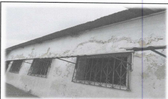
Foto 10: Cambio e instalación de estructura de soporte metal por metal mas lamina troquelada aluzinc calibre 26. Lado exterior frontal del salon de clases donde se intervendrá.
