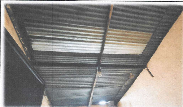
Foto 9: Cambio e instalación de estructura de soporte y lámina por lámina troquelada aluzinc calibre 26 (incluye pernos) en el módulo de cocina.
