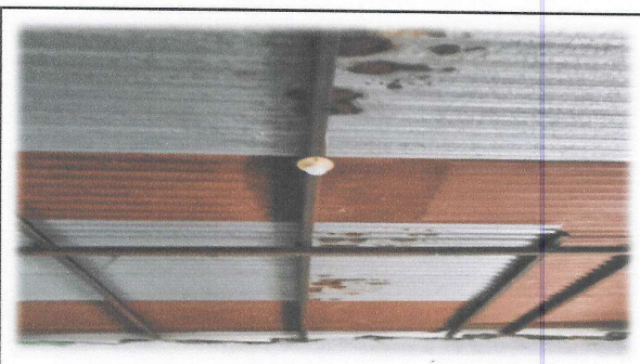
Foto 12: Cambio e instalación de lámina por lámina troquelada aluzinc calibre 26 (incluye pernos).
