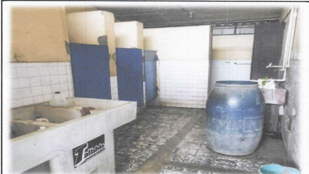
Foto 3: Mejoramiento de servicios sanitarios (Incluye reparación, cambio de tubería, artefactos, azulejo y muros divisores.
