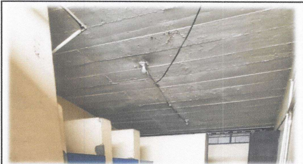
Foto 5: Cambio e instalación de sistema electrico (fuerza e iluminación) incluye ducto, cajas octogonales, abrazaderas, cables, interruptores, plafoneras, focos ahorradores de alta potencia y tomacorrientes.
