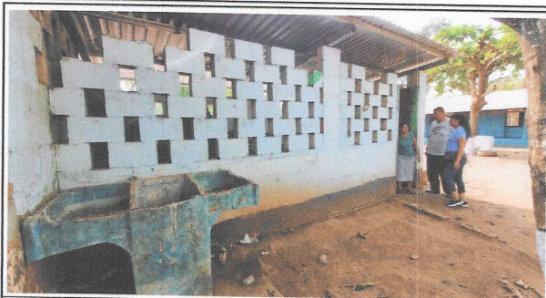
Foto 7: Mejoramiento y reparación en el modulo de cocina.
