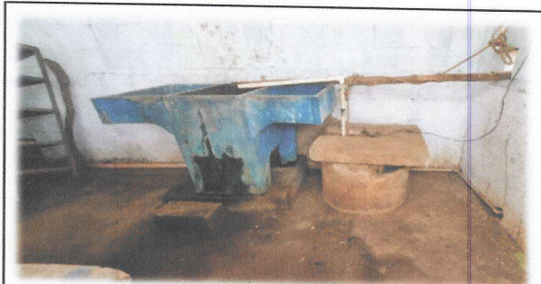
Foto 10: La escuela posee un beneficio de pozo de agua que beneficia a toda la comunidad estudiantil, con la deficiencia que la actual bomba se encuentra quemada, por ende no esta en uso el pozo y cadecen de agua.
