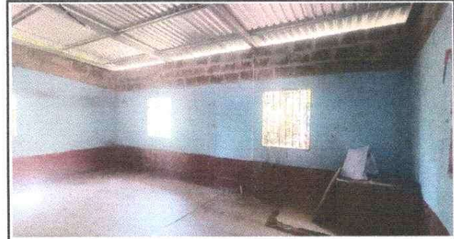
Foto 10: Instalacion de balcones
