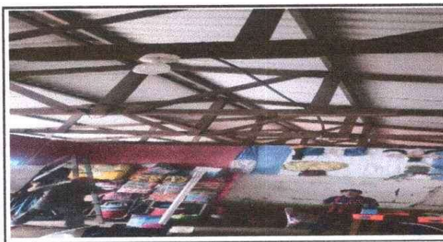
Foto 5: Instalación de sistema electrico
