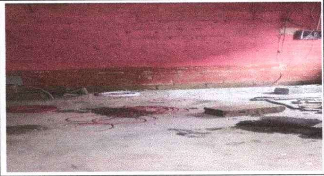
Foto 2: Instalación de sistema electrico
