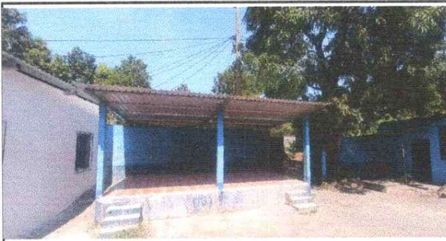
Foto 9: Cambio de techo de escenari o e instalacion de piso ceramico
