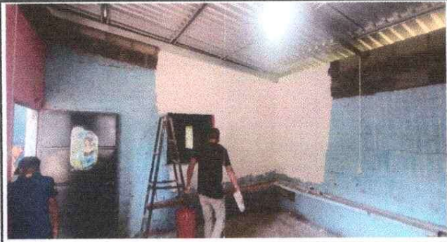
Foto 4: Instalación de sistema electrico
