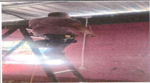
Foto1: Instalación de sistema electrico
