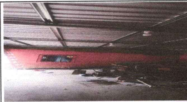
Foto 3: Instalación de sistema electrico
