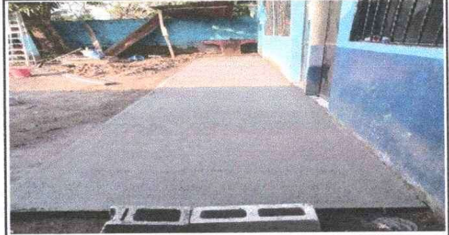
Foto 2: Fundicion de banqueta
