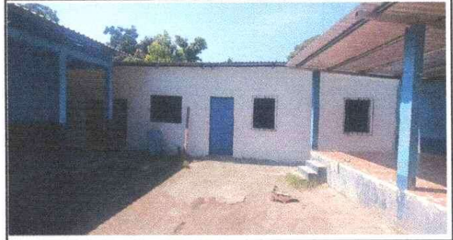
Foto 8: Repello frontal y puerta instalada
