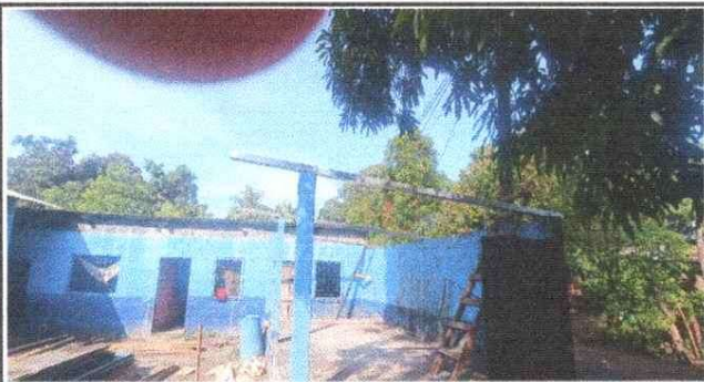
Foto 7: Montaje de estructura de lamina en escenario
