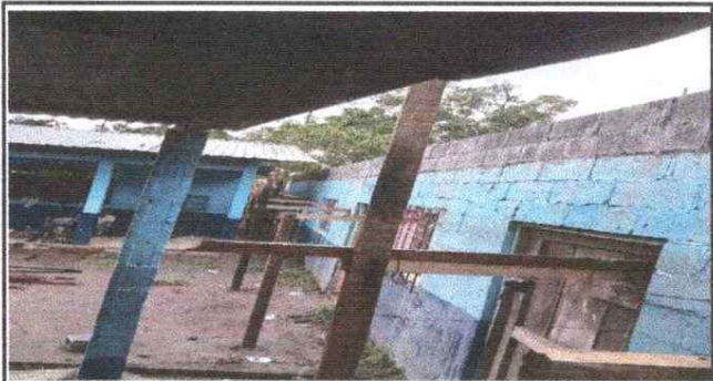
Foto 4: Levantado de tres hiladas de block en toda el area a remodelar
