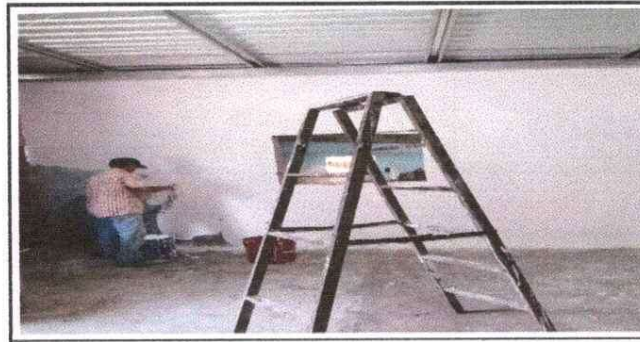
Foto 6: Colocación de estructuta de metal
