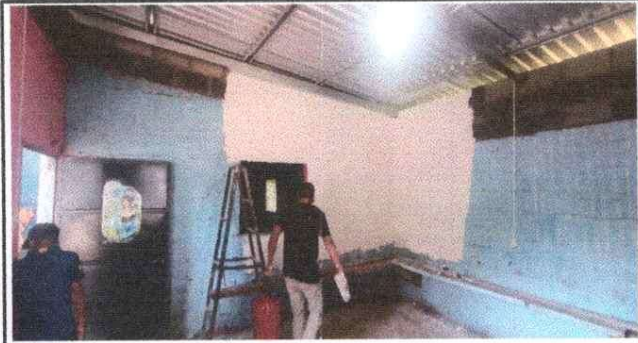
Foto 4: Instalación de sistema electrico
