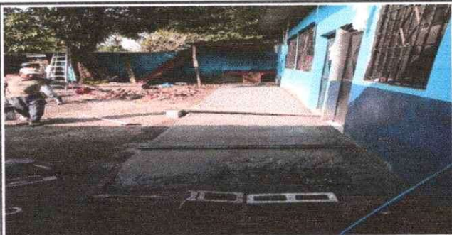
Foto 7: Fundición de torta de cemento
