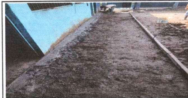
Foto 11: Fundición de cemento
