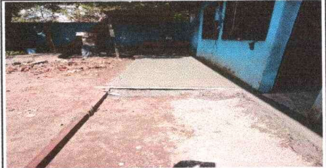
Foto 8: Fundición de cemento
