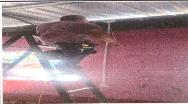
Foto1: Instalación de sistema electrico
