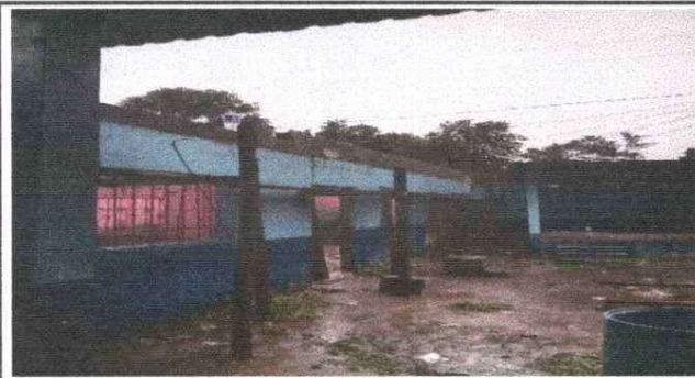
Foto 3: Levantado de block tres hiladas en toda la estructura
