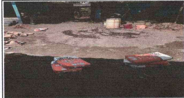
Foto 10: Colocación de piso cerámico en el escenario
