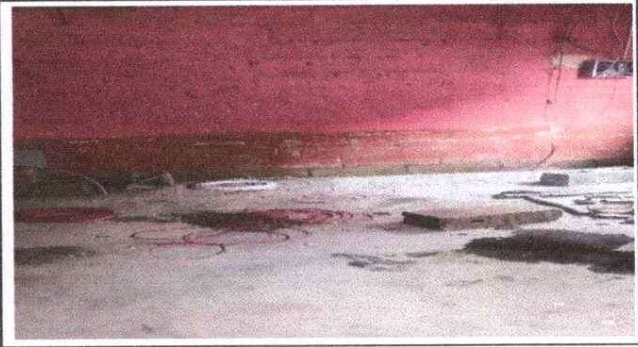
Foto 2: Instalación de sistema electrico
