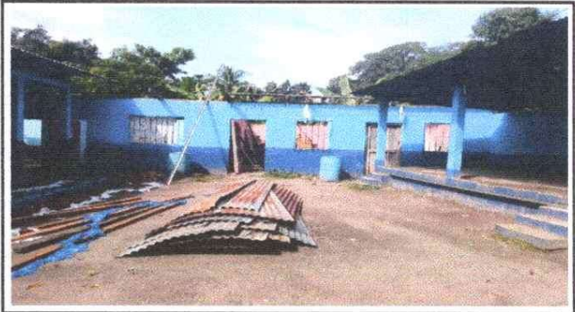
Foto 2: Desinstalación de estructura deteriorada
