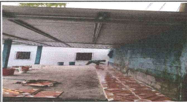
Foto 9: Colocacion de estructura metalica en el escenario
