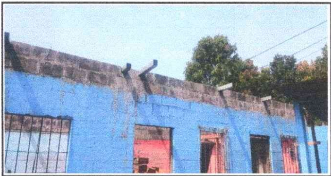
Foto 6: Colocación de estructura de metal
