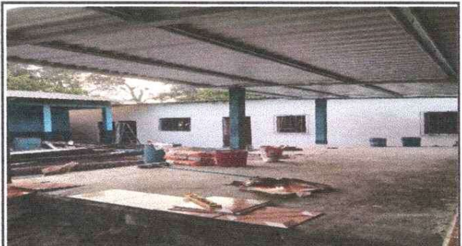
Foto 8: Colocación de piso ceramico en el escenario
