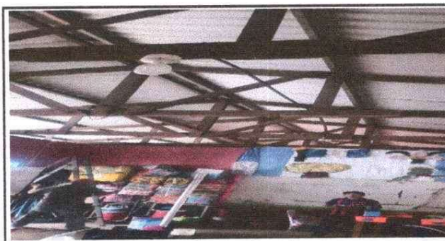
Foto 5: Instalación de sistema electrico
