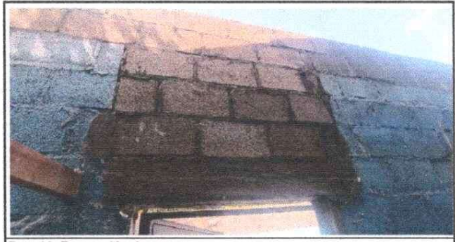
Foto 12: Reparación de muro
