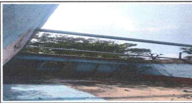
Foto 5: Colocación de estructura de metal
