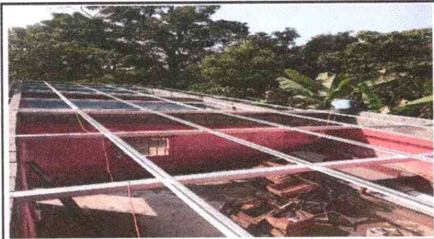
Foto1: Instalacion de estructura de metal
