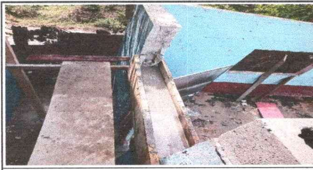
Foto 11: Reparación de muro
