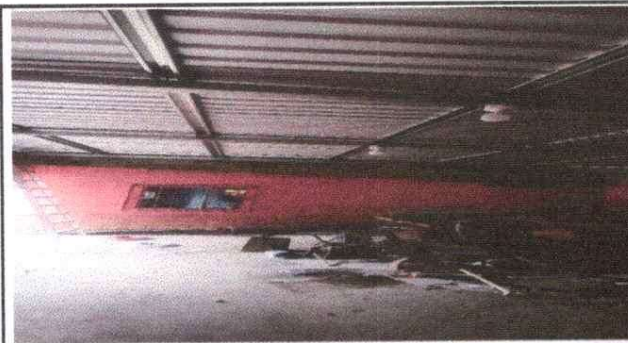
Foto 3: Instalación de sistema electrico
