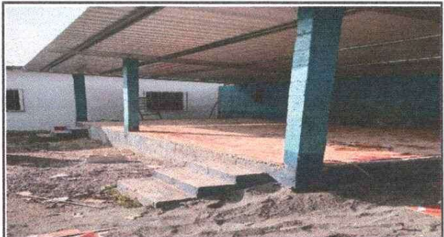
Foto 10: Colocación de piso ceramico en el escenario
