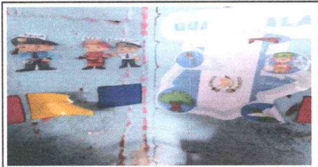
Foto 11: Reparación de muro
