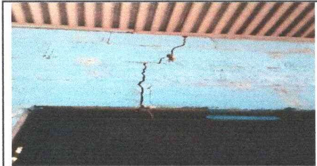
Foto 12: Reparación de muro
