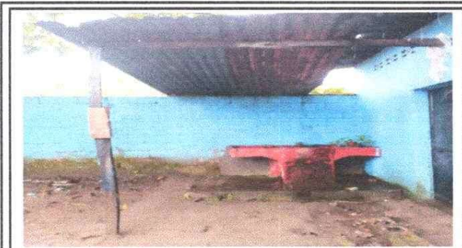
Foto7: Sustritiución de lamina
