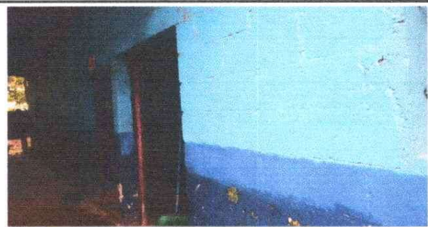
Foto 5: Reparacion de muro
