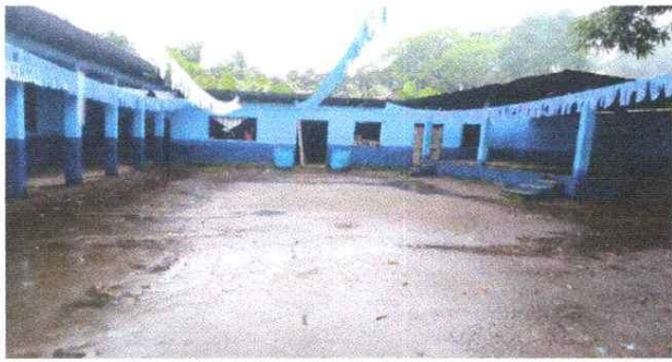
Foto1: Sustitucion de lamina por lamina troquelada
