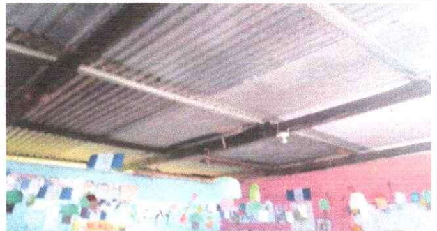
Foto 4: Sustitución de lamina y Reparación de sistema eléctrico
