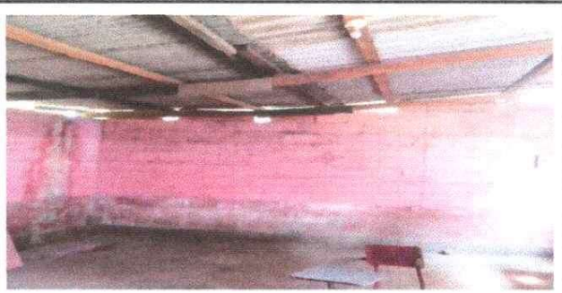
Foto 6: Sustitucion de lamina y sustitución de sistema eléctrico
