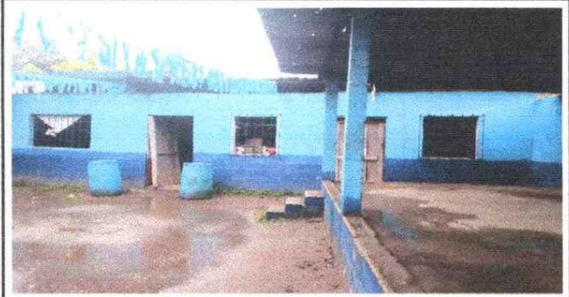
Foto 8: Sustritiución de lamina y Reparacion de sistema eléctrico
