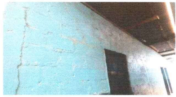
Foto 2: Reparación de Muro
