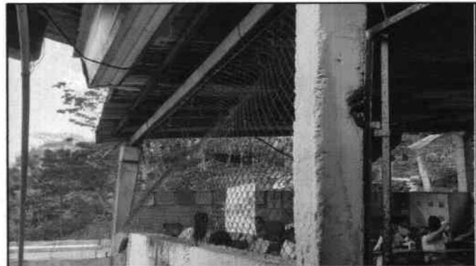
Foto 10: Es necesario el mejoramiento por seguridad de muro lateral de block en módulo de aulas.
