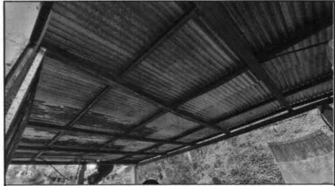
Foto 8: Se detecta la necesidad de darle mantenimiento a estructura (lijado, cambio de tubo, cepillado, sujeciones , aplicaciones de pintura).
