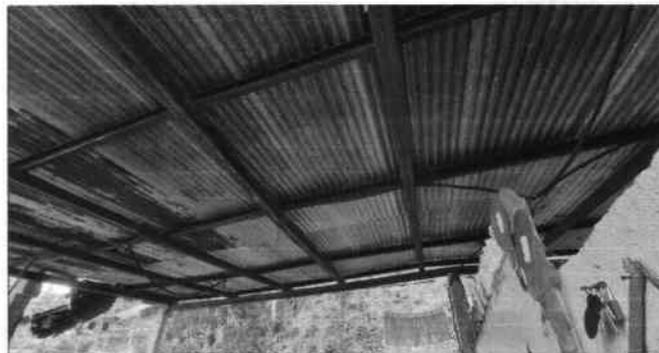
Foto 6: Cambio e instalación de lamina por lamina troquelada aluzinc calibre 26, incluye tornillos en el primer módulo de aulas.
