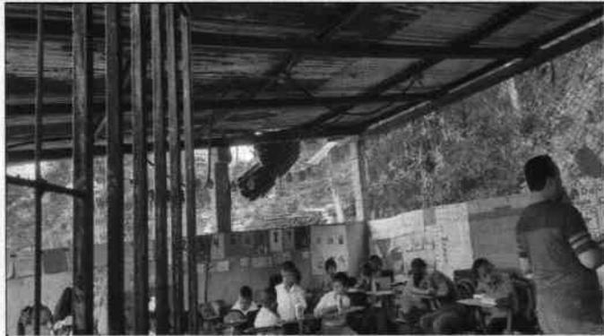
Foto7: Cambio e instalación de lamina por lamina troquelada aluzinc calibre 26, incluye tornillos en el segundo módulo de aulas
