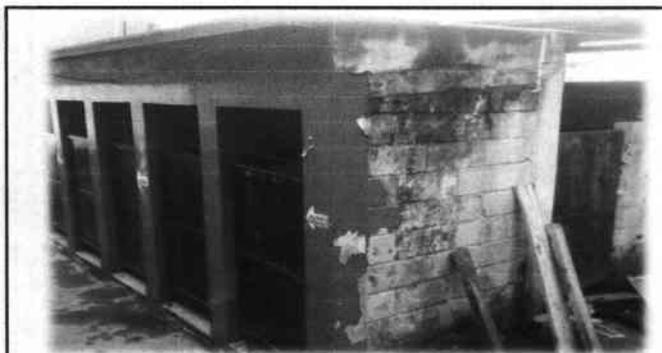
Foto 5: Es necesario aplicar pintura en exterior e interior del módulo de servicios sanitarios.
