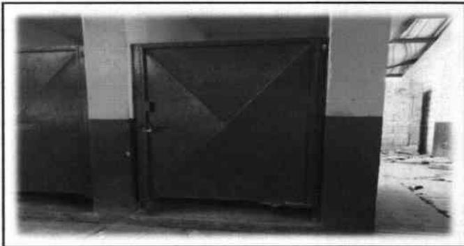
Foto 6: Presenta deteriorados en las puertas de los cubiculos de los servicios sanitarios, lo necesario es darle un debido mantenimiento, ya que aún presenta condiciones adecuadas.
