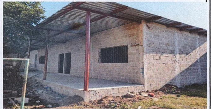
Foto 4: construccion de muro perimetral
