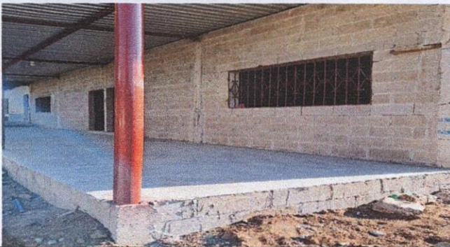
Foto 3: sustitución de muro perimetral
