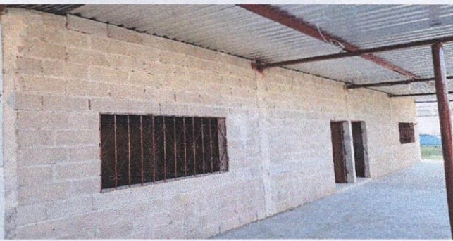
Foto 5: sustitucion de ventana balcon
