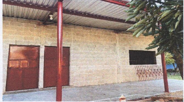
Foto 4: construcción de muro perimetral
