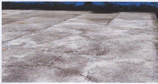
Foto 1: Sustrucción de Piso
