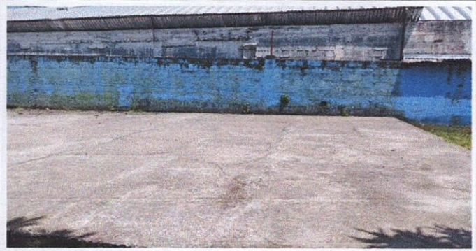
Foto 2: Sustrucción de techo
