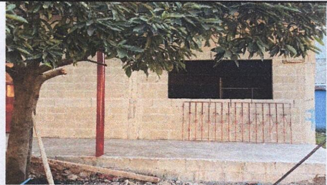
Foto 6: sustitucion de ventana balcon
