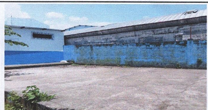
Foto 4: Sustrucción de Muro Perimetral.
