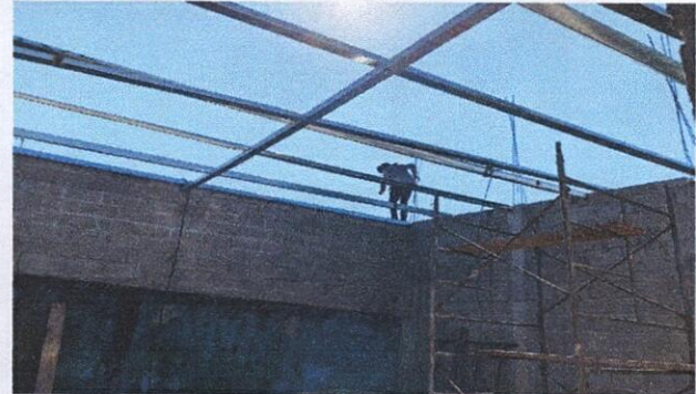
Foto 2: sustitución de techo
