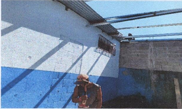
Foto1: sustitución de techo
