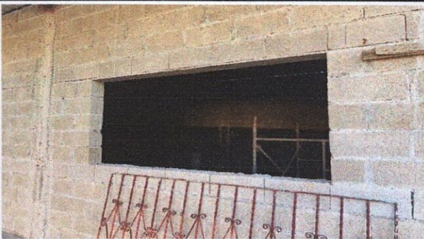
Foto 5: sustitucion de ventana balcon
