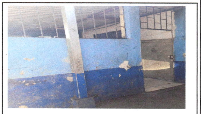
Foto 10: Paredes de aulas en pasillo
