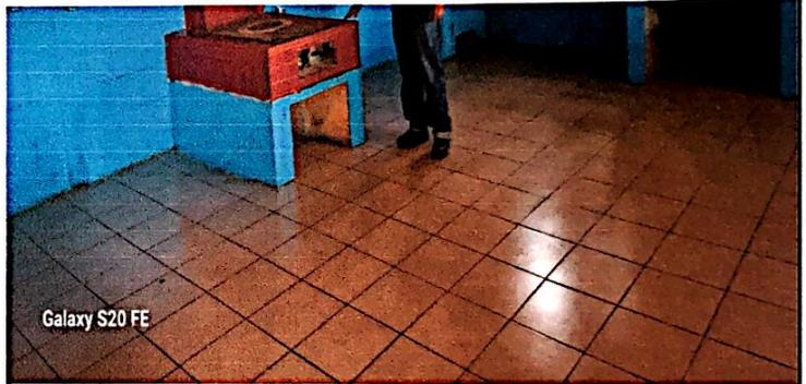
Foto 4: Sustitución e instalación de piso ceramico antideslizante en el módulo de cocina, finalizado al 100%
