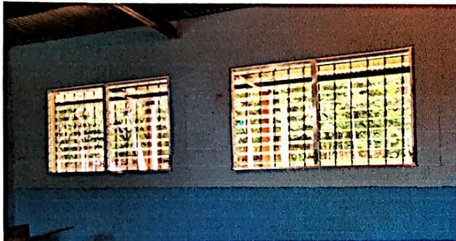
Foto 9: Cambio e instalación de ventana de aluminio mill finish mas paleta en módulo de 4 aulas + salón de computo. Finalizado al 100%
