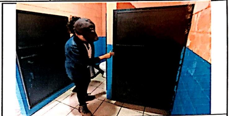
Foto 8: Mantenimiento y reparación de puertas 1.00 m x 2.18 m (Lijado, pintado y sustitución) finalizado al 100%.
