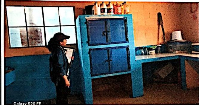
Foto 3: Mejoramiento en módulo de cocina, incluye reparación de muebles de cocina mas azulejo, colocación de puertas metalicas en gabinetes. Finalizado al 100%
