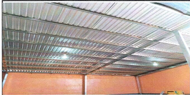
Foto 1 : 1.1 sustitución de lamina por lamina troqueñada aluzinc calibre 26 Trabajo finalizado con lamina nueva
