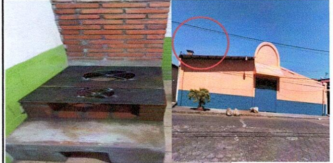
Foto 21 : 20.2 sustitución de estufa rural (completa ) incluye chimenea y plancha de metal. Esta fotografia muestra la estufa rural completa ya finalizada con su respectiva chimenea en el techo
