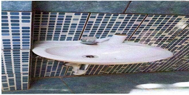
Foto 20 : 19.17 Inatación de lavamanos esta fotografia muestra el lavamanos ya instalado
