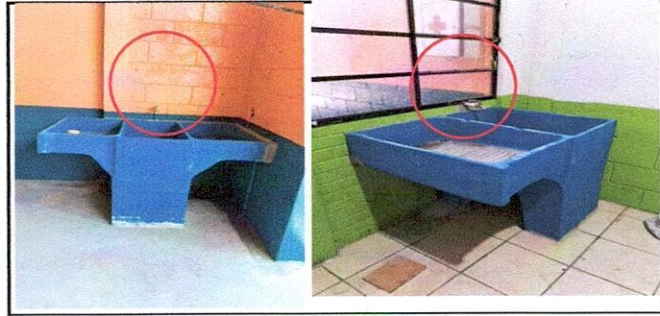
Foto 25 : 19.22 Instalación de chorros La fotografia muestra en los circulos rojos los chorros ya instalados
