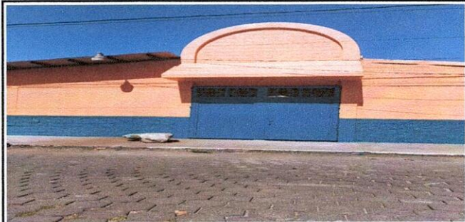
Foto 3 : 4.5 sustitución de portón de metal portón nuevo de la entrada principal finalizado
