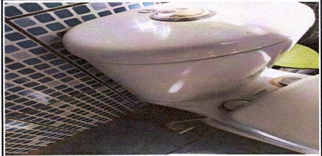
Foto 8 : 10.2 sustitución de accesorios inodoro contrallave , tuvo de abasto y tanque)(la fotografía muestra baños ya con sus servicios al 100 %
