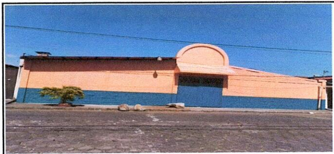
Foto 17: 19.5 Fabricación e instalación de portón de metal de ingreso Esta fotografía muestra el portón ya instalado en la entrada principal del establecimiento.
