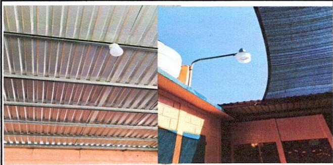
Foto 13 : 17.11 Reparación de cableado eléctrico Esta fotografía muestra el cableado eléctrico funcionando ya terminado
