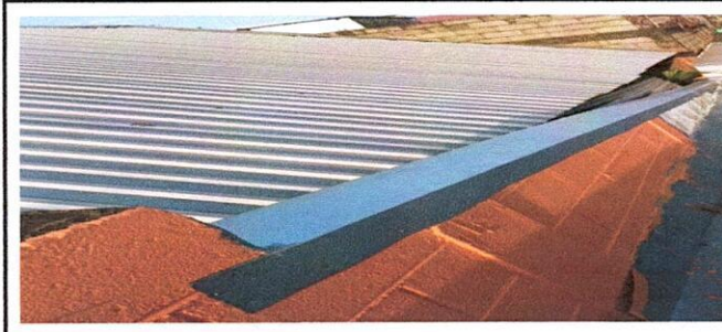
foto. 6 7.1 sustitución de canal de metal Esta fotografia muestra el canal de techo cerca de la bodega instalado cien por ciento
