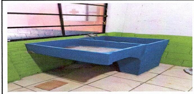
Foto 23: 20. 11 sustitución de pila de cemento de un lavadero Esta fotografia muestra la pila de un lavadero de cemento ya instalada en el espacio de cocina,
