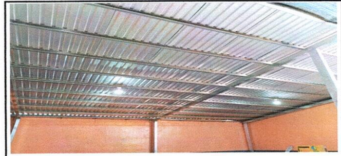
Foto 18 19.7 Instalación de estructura portante de metal Esta fotografía muestra el trabajo terminado de estructura de techo
