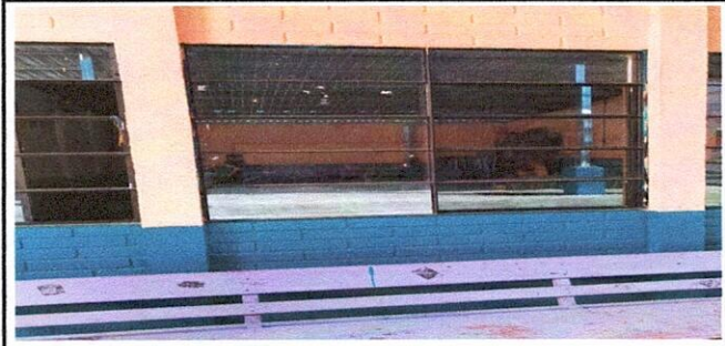
foto 4 : 5.1 mantenimiento a estructura de metal de ventanas La fotografia muestra estructuras de metal cienporciento restructuradas
