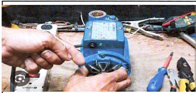
Foto 16: 18.6 reparación de bomba de agua Esta fotografía muestra la bomba en proceso de reparación
