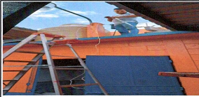
Foto13 : 17.11 Reparación de cableado eléctrico Esta fotografía muestra el cambio de cableado eléctrico.
