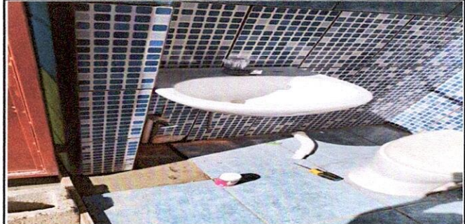
Foto 8 : 10.2 sustitución de accesorios inodoro contrallave , tuvo de abasto y tanque)(la fotografía muestra algunos accesorios que se colocaran en el deposito de baños.
