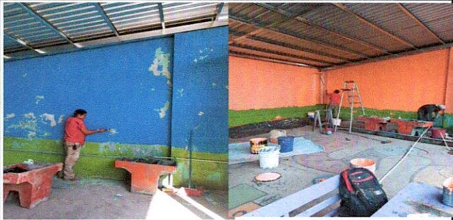
Foto 7 9.1 pintura en muros interiores y exteriores Esta fotografía muestra el trabajo en preparación de áreas a pintar y el proceso de pintura ya iniciado.
