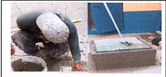
Foto 10 14.5 Reparación de tapaderas de cajas Esta fotografía muestra la elaboración de un muro para dar seguridad a la tapadera del deposito subterráneo de agua potable.
