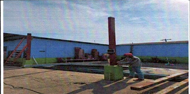
Foto 2 : 2.3 Isustitución de estructura de soporte de metal, por metal ( En esta fotografia se muestra el desmontaje de laestructura en mal estado )
