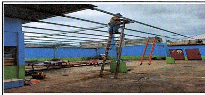
Foto 19: 19.7 Instalación de estructura portante de metal Esta fotografía muestra el trabajo de instalación de estructura de metal del techo
