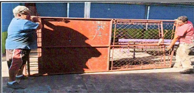
Foto 3 : 4.5 sustitución de portón de metal esta imagen muestra el desmontaje del portón viejito
