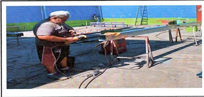
foto. 6 7.1 sustitución de canal de metal Esta fotografia muestra la preparación del canal que se colocara en el techo del salón de clases cerca de la bodega
