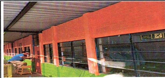
foto 4 : 5.1 mantenimiento a estructura de metal de ventanas Esta fotografia muestra el proceso de mantenimiento en la estructura de las ventanas de los diferentes salones .
