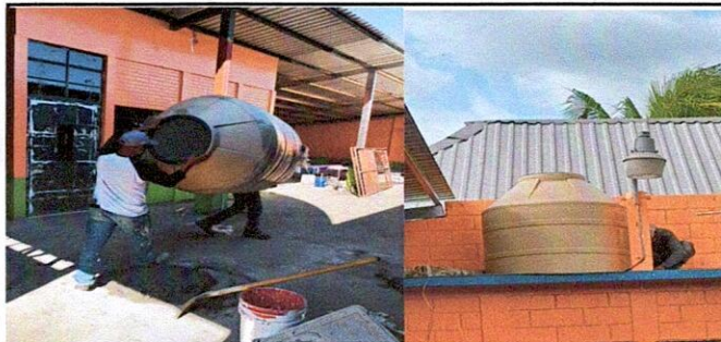
Foto 15 : 18.2 Sustitución de deposito de agua 1100lt. Esta fotografía muestra el deposito nuevo y su proceso de instalación en el lugar indicado.
