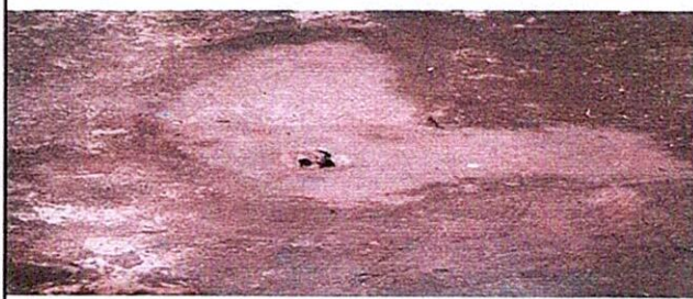
Foto 9: 14.1 Mantenimiento a reposaderas
