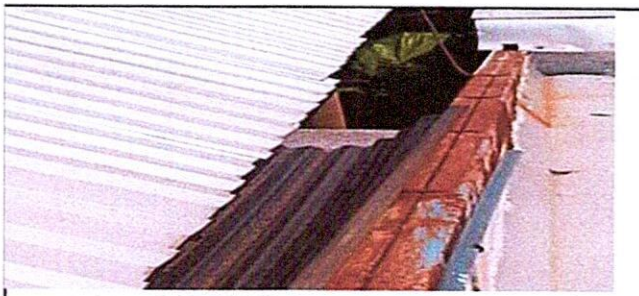
Foto 6: 7.1 Sustitución de canal de metal
