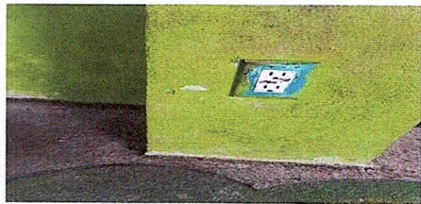
Foto 14 : 17.8 Sustitución de tomacorrientes dobles
