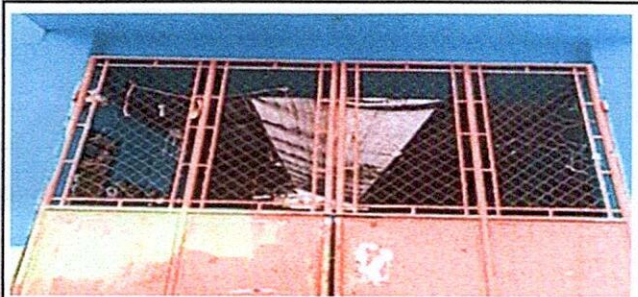
Foto 3: 4.5 Sustitución de portón de metal
