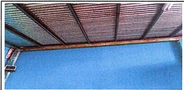
Foto 1: 1.1 Sustitución de lamina, por lamina troquelada aluzinc calibre 26
