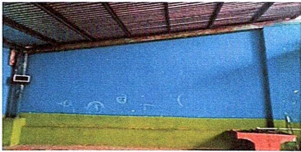
Foto 7: 9.1 Pintura en muros exteriores e interiores
