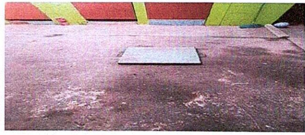
Foto10: 14.5 Reparación de tapaderas de cajas
