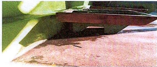
Foto 21: 20.11 sustitución de pila de cemento de un lavadero de un lavadero
