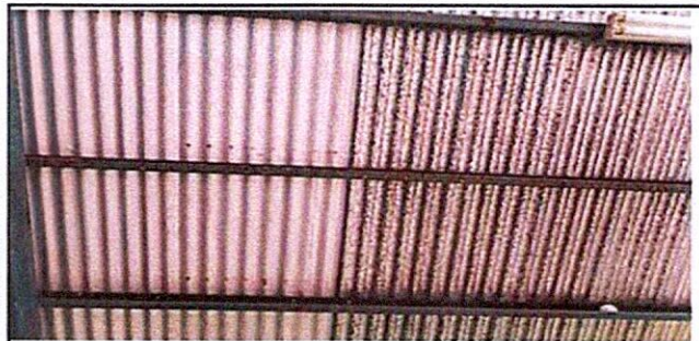
Foto 2: 2.3 Sustitución de estructura de soporte de metal, por metal
