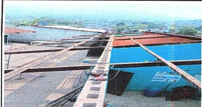
FOTO 1: DESINSTALACIÓN DE LÁMINA EXISTENTE
