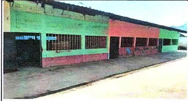
Foto 2: Sustitución de lámina, por lámina troquelada aluzinc callbre 26'
