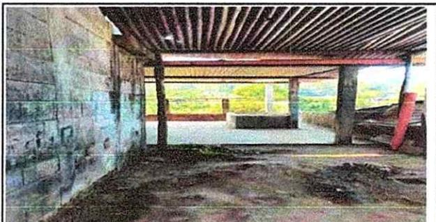
Foto 6: Sustitución de lamina por lamina troquelada aluzinc callbre 26
