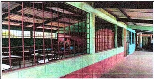
Foto 5: Sustitución de lamina por lamina troquelada aluzinc callbre 26
