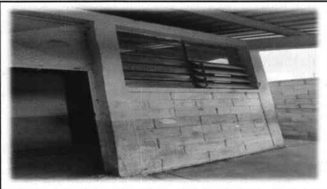
Foto 7: En el Área de los salones de clases, se instalarán balcones en la parte frontal de las aulas y servicios sanitarios, por situación de inseguridad en el lugar,
