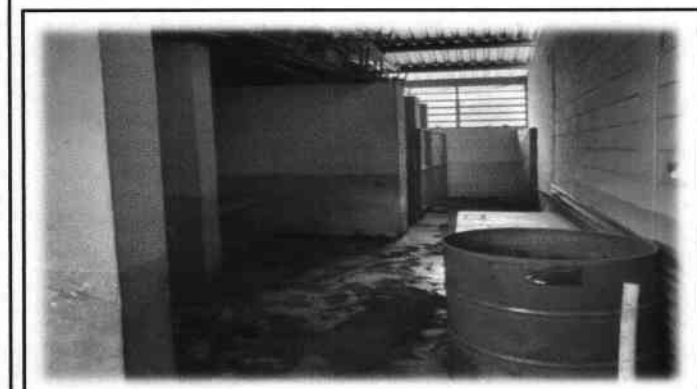
Foto 3: Área de servicios sanitarios (niñas, niños y docentes). Se realizarán diversas mejoras ya que se pudo observar múltiples necesidades.
