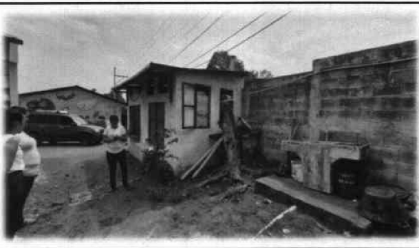
Foto 6: Mejoramiento y Reparaciones en el modulo de cocina.
