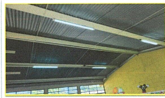
Foto 4: Sustitución de lámparas
