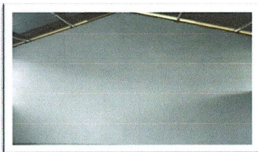
Foto 3: Repello en muro
