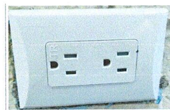
Foto 6: Sustitución de tomacorrientes dobles
