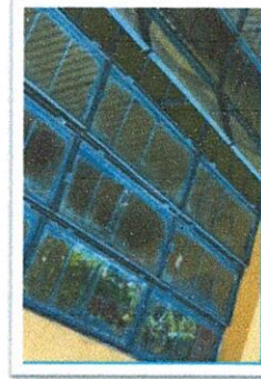
Foto 4: Sustitución de vidrios
