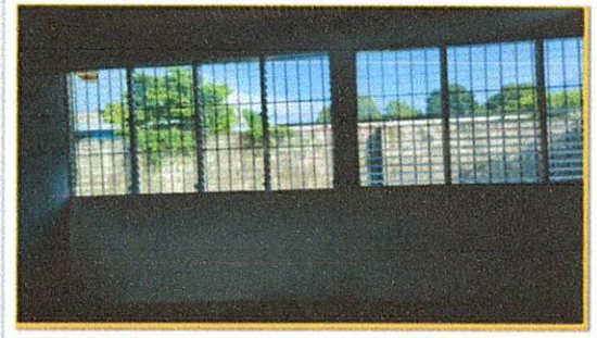
Foto 6: Sustitución de estructura de metal de ventana
