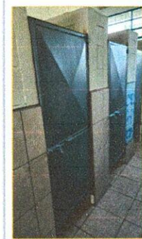
Foto 2: Mantenimiento a estructura de puertas (lijado, cambio de tubo , cepillado, sujeciones, aplicación de pintura)
