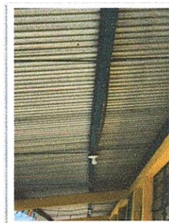
Foto 2: Reparación de cableado electrico
