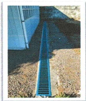
Foto 5: elaboracion de cunetas por filtracion de agua en los Modulos
