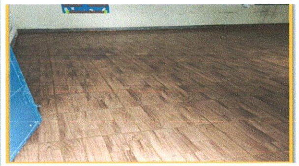
Foto1: Sustitución de piso cerámico
