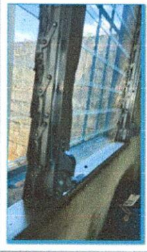
Foto 3: Mantenimiento a marcos de aluminio mill finish
