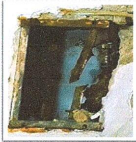
Foto1: Sustrucción de tablero de flipones
