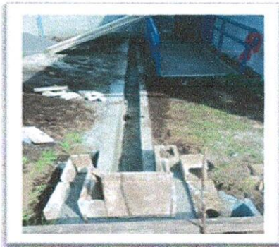
Foto 5: elaboracion de cunetas por filtracion de agua en los Modulos
