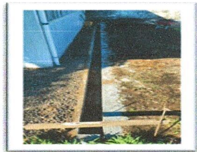
Foto 6: elaboracion de cunetas por filtracion de agua en los Modulos
