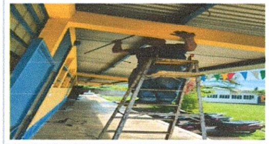
Foto 2: Reparación de cableado electrico
