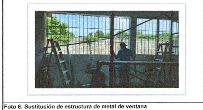
Foto 6: Sustitución de estructura de metal de ventana
