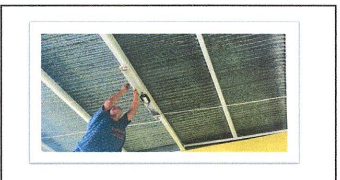
Foto 4: Sustitución de lámparas
