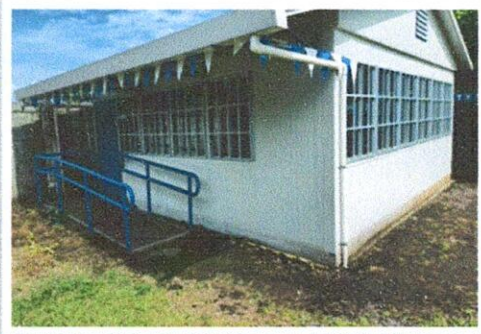
Foto 5: elaboracion de cunetas por filtracion de agua en los Modulos
