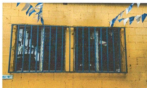
Foto 4: colocacion de pestaña a la ventana por filtracion de agua
