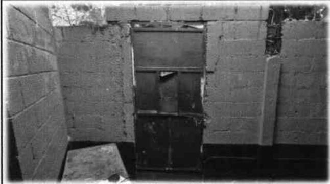
Foto 7: Existe la necesidad de la reparación y mantenimiento de portón de ingreso de la calle hacia la cocina y reparación de muro.
