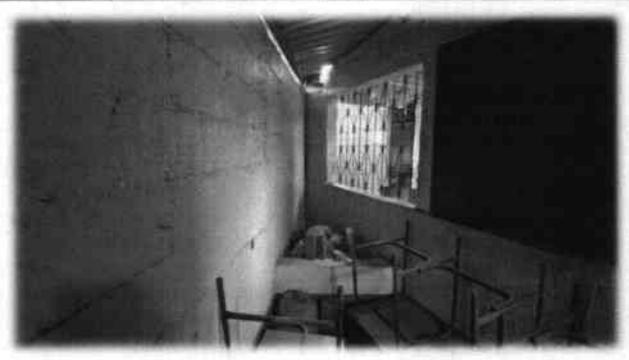
Foto 8: Cambio e instalación de lámina por lámina troquelada aluzinc calibre 26 más colocación de electromalla por seguridad.
