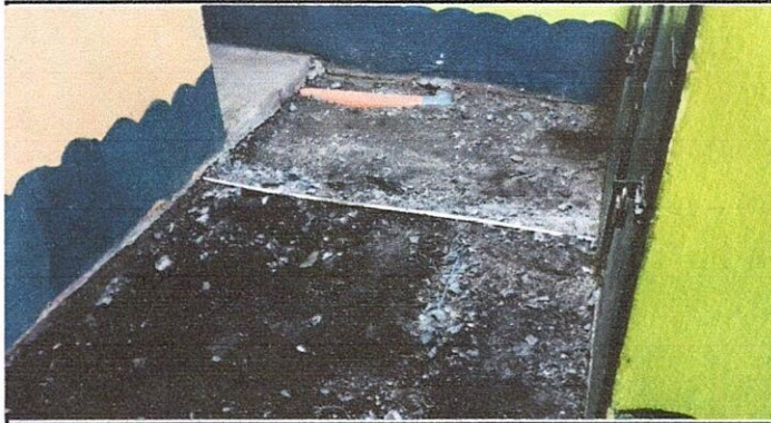
Foto 7: Sustitución Inodoro. Dirección
