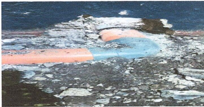
Foto 17: Sustitución a tubería PVC línea principal aguas negras.
