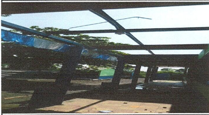
Foto1: Sustitución de lámina, por lámina troquelada aluzinc calibre 26 aula No. 6
