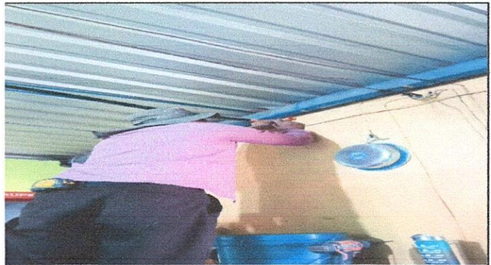
Foto 10: Reparación de cableado eléctrico dirección y cocina.
