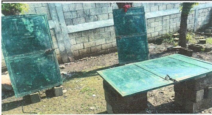
Foto 3: Mantenimiento a estructura (lijado,cambio de tubo, cepillado, sujeciones, aplicación de pintura) A 6 Puertas servicios sanitarios de alumnos
