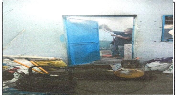
Foto 4: Sustitución de Chapa en puerta de cocina.
