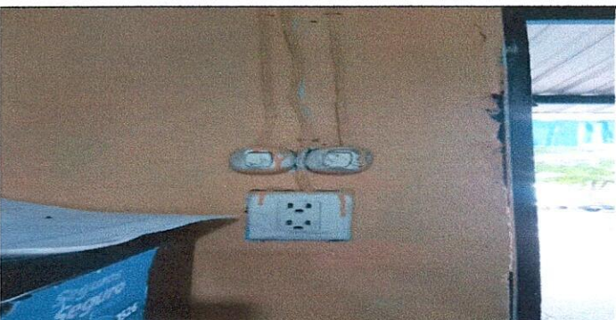
Foto 11: Sustitucion de interruptores simples.
