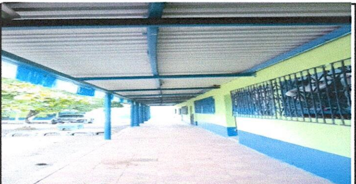
Foto 12: Intalación de unidades luz ( incluye interruptor, ducto y cable electrico. Corredor de los salones.
