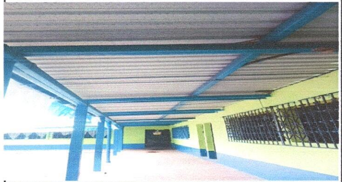
Foto 14: Instalacion de unidades luz 8incluye interruptor, ducto y cable electrico) corredor de la escuela
