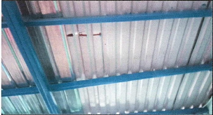
Foto 1: Sustitución de lamina, por lamina troquelada aluzinc calibre 26 aula No. 06
