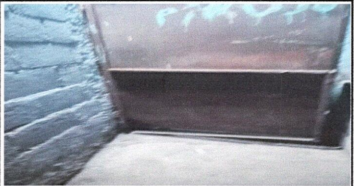
Foto 2: Sustitución de Puerta en la bodega de la cocina. Con chapa.
