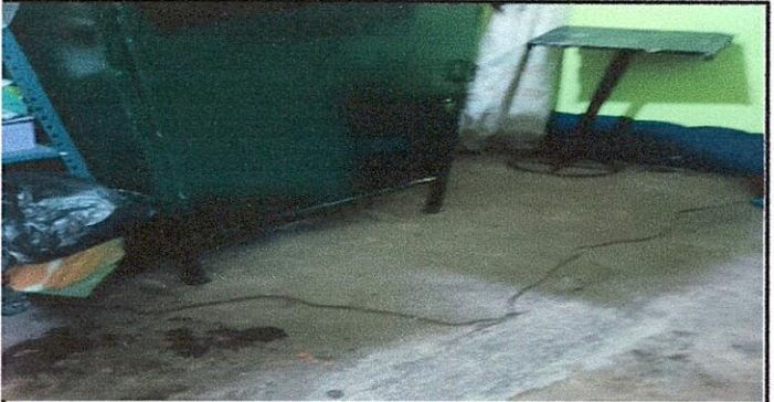
Foto 6: Reparación de piso de cemento líquido en una parte de dirección .
