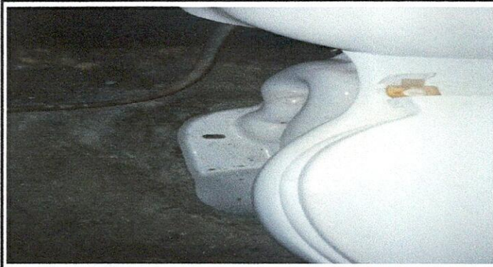
Foto7: Sustitucion Inodoro. Dirección
