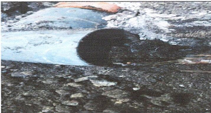
Foto 17: Sustrucción a tubería PVC línea principal aguas negras.
