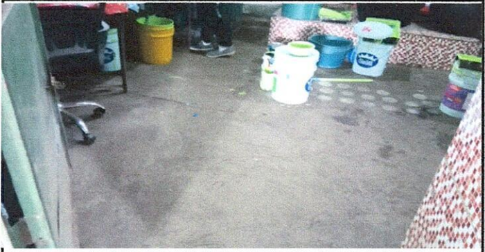
Foto 5: Reparación de piso de torta de concreto.
