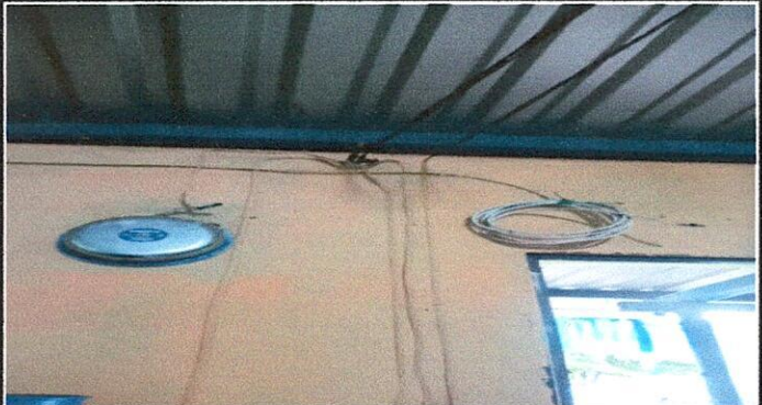
Foto 10: Reparación de cableado electrico dirección y cocina .
