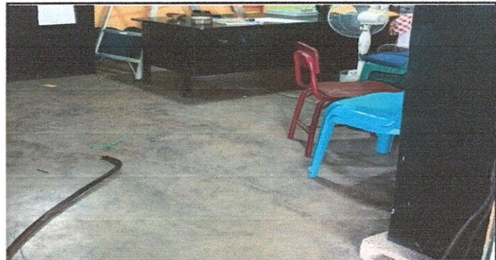
Foto 18: Reparación de piso de torta de concreto en la dirección.
