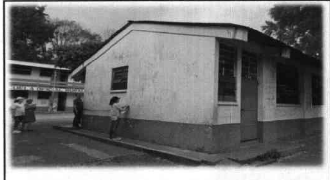
Foto 10: Proceso de medición de los módulos de aulas durante la visita técnica.
