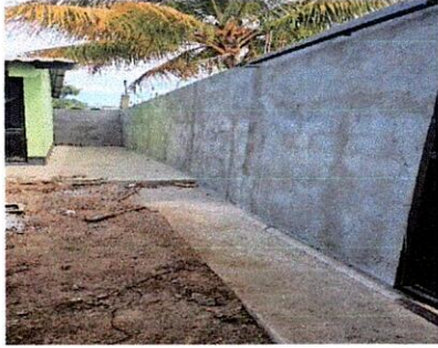
Foto1: Reparación Muro Perimetral de block lado de adentro y de afuera
