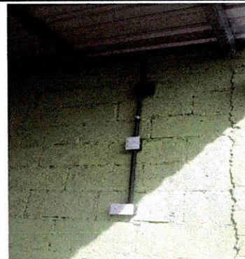
Foto 4: Sustrucción de Interruptores dobles
