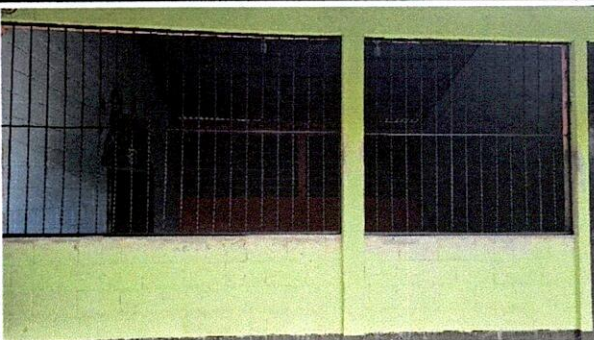
Foto 5: Sustitución de Balcones
