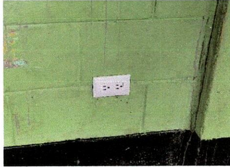
Foto1: Sustrucción de tomacorrientes dobles
