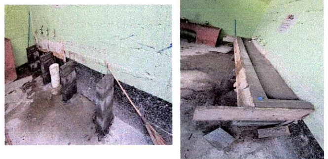
Foto 6: Sustitución de Lavamanos
