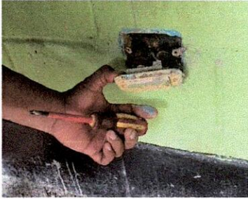
Foto1: Sustitucion de tomacorrientes dobles
