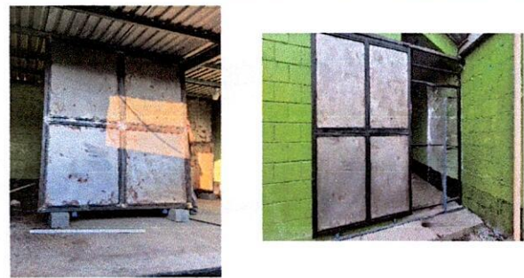
Foto 4: Sustitución de porton de Metal
