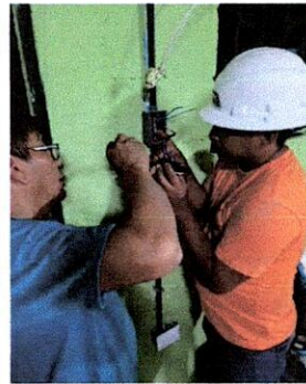
Foto 4: Sustitución de interruptores dobles
