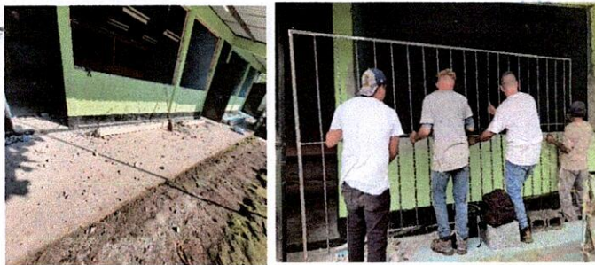
Foto 5: Sustitucion de Balcones
