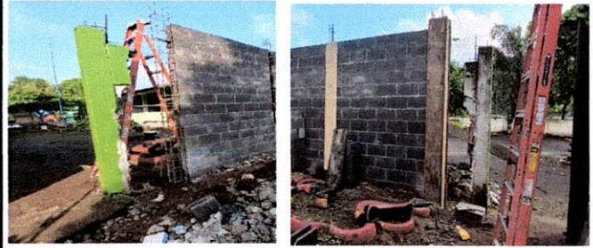
Foto 2: Sustitución de porton de metal
