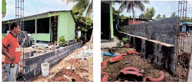
Foto1: Reparación muro perimetral de Block lado de adentro y de afuera
